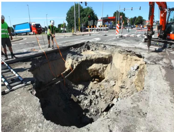
De herstellingswerken aan het zinkgat zijn volop aan de gang © Danny Sagaert
